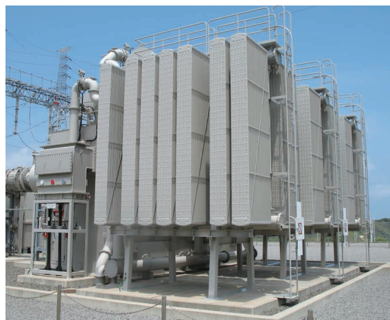
《変圧器設備 (中央が当社パネルラジエーター)》
